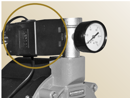
Motobomba com o pressostato 16-33.
